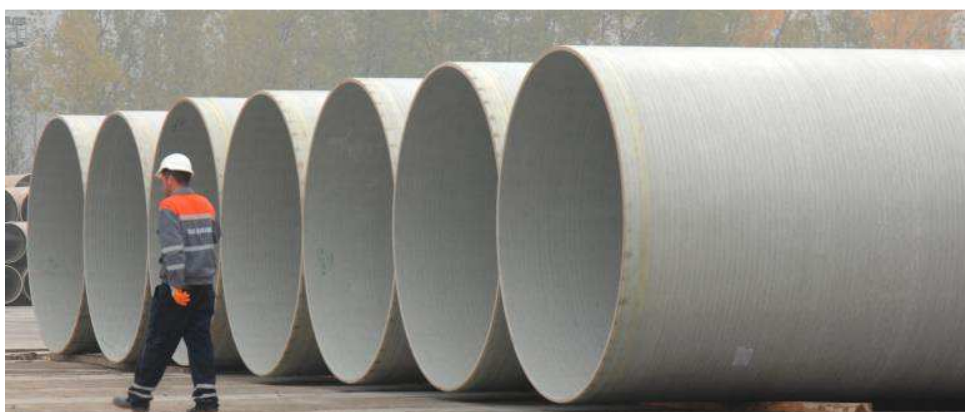
Obrázek 4: Uložení trubek v jedné řadě
