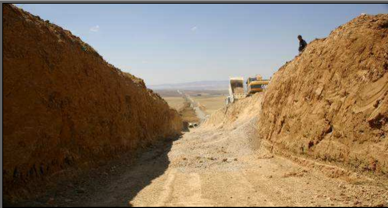
Podkladová vrstva po stabilizaci podloží
