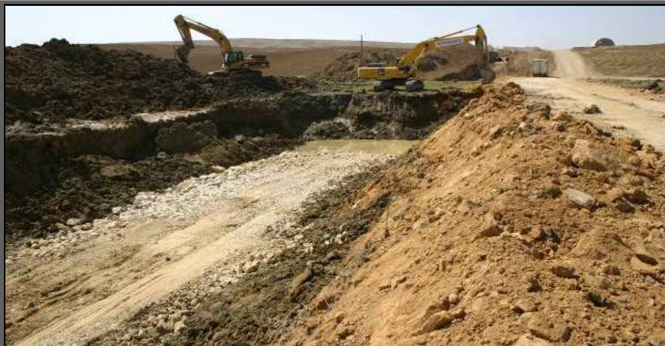
Stabilizační práce pro podkladovou vrstvu výkopu (základ)
